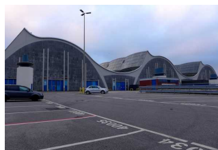
Parkplatz direkt vor der Halle
